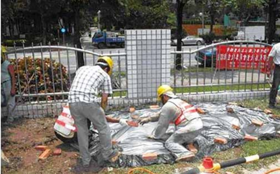
圖 19 土壤拌藥加水後，需覆蓋黑色不透光之厚塑膠布 2 至 3 星期。
