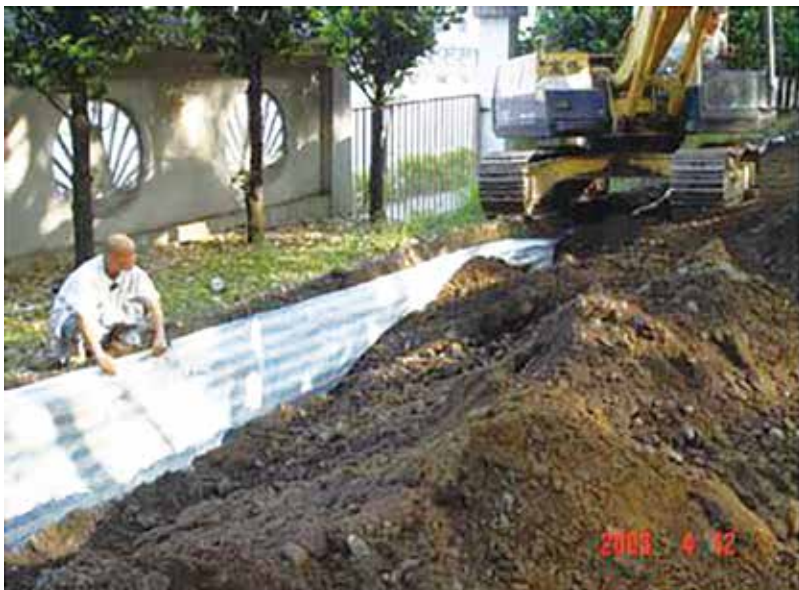
圖 20 以強力塑膠布放於深溝間以阻隔根部接觸，並回填土壤，以阻止病根與健康根接觸傳染。
