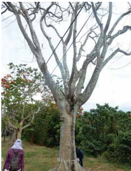
圖 11 針對感病樹木評估進行移除及感病地的處理作業。
