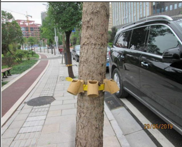
風景區街道為維護樹木不傾倒，設計保護支撐架盒情形
