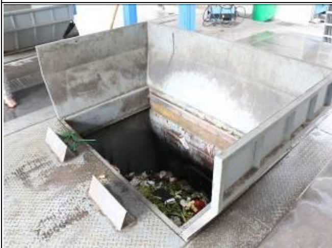
紹興市越城區垃圾中轉站之儲存坑
