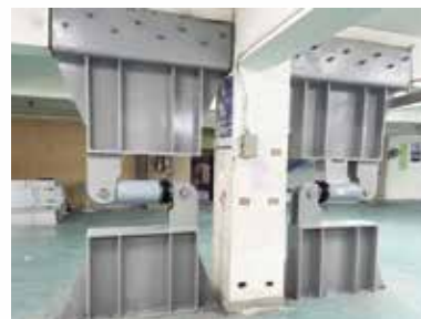
▲ 民權市場補強工程阻尼器
