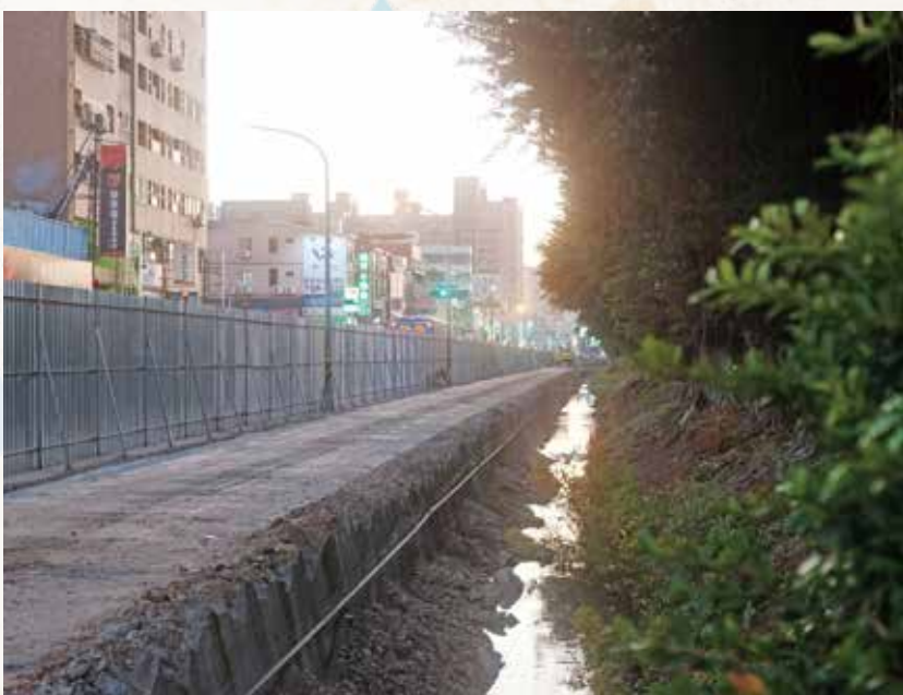
▲ 台化街雨水下水道已開工，請用路人行經此處注意安全。
