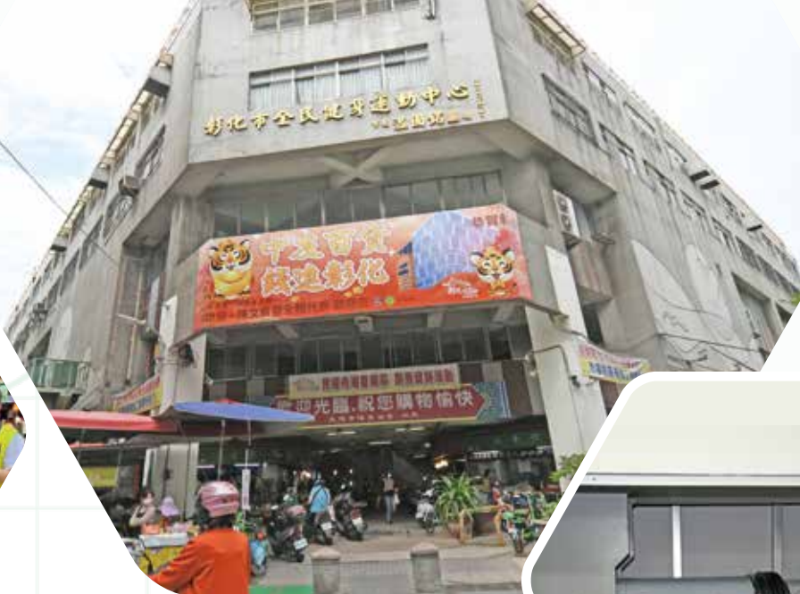
▲為解決 921 大地震後結構安全疑慮 民權市場 3 年多前完成補強工程
